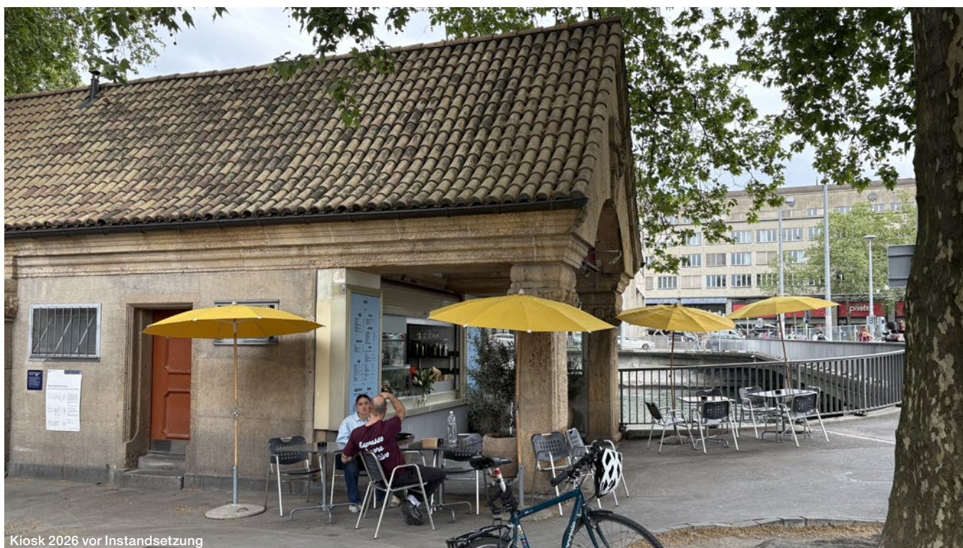
Kiosk 2026 vor Instandsetzung
